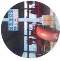
ระบบท่อน้ำดับเพลิง
